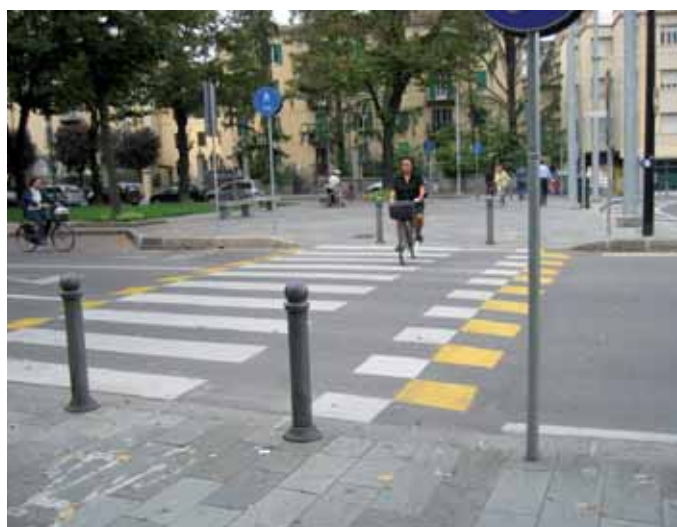
Foto 10 Attraversamento ciclopedonale rialzato con rampe colorate (Parma).
