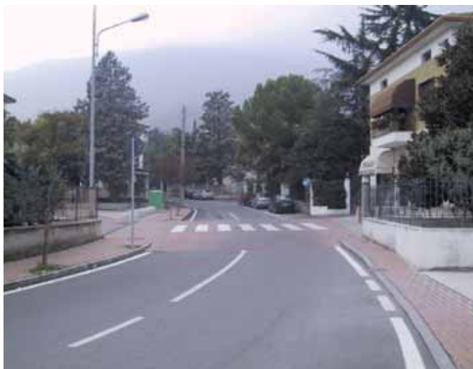
Foto 10 Attraversamento ciclopedonale rialzato con rampe colorate (Parma).
