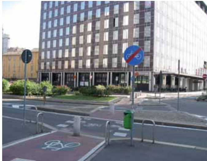
Foto 08 Errata apposizione di segnale di fine pista in corrispondenza di un attraversamento ciclabile (Milano).
