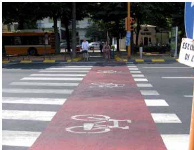
Foto 18 Attraversamento ciclabile in rotonda con fondo colorato di rosso (Lodi).
