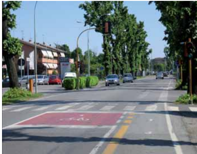
Foto 16 Linea di arresto avanzata combinata con corsia ciclabile di attestamento (Austria).
