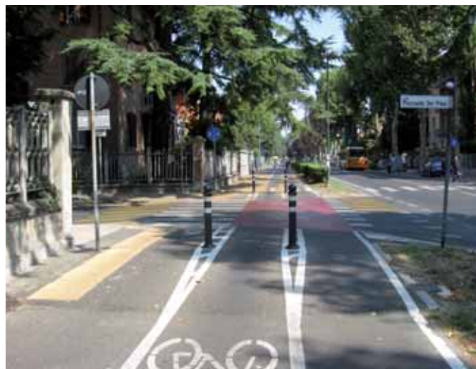
Foto 11 Segnale di "dare precedenza" e attraversamento ciclopedonale (Parma).
