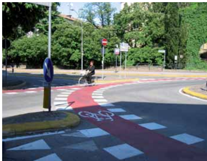
Foto 18 Attraversamento ciclabile in rotonda con fondo colorato di rosso (Lodi).
