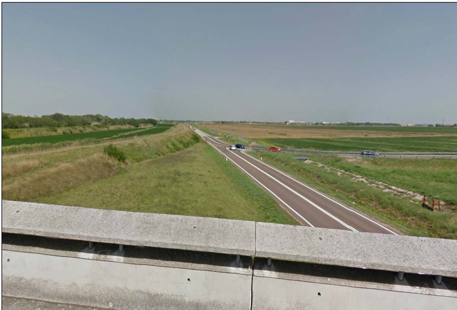
Km 057 Bibione – Ponte sul Tagliamento
